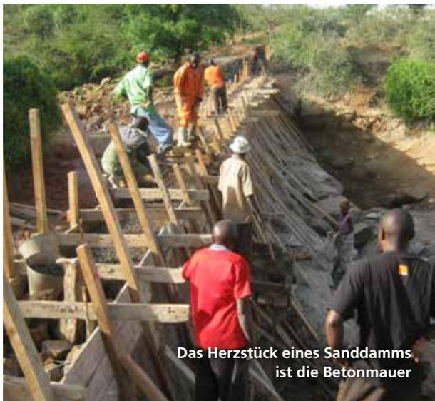
Das Herzstück eines Sanddamms ist die Betonmauer
